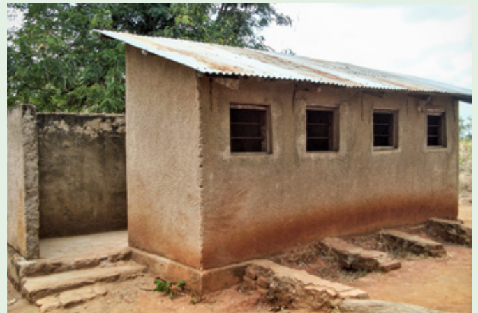
▲ Die Toiletten der Ngoheranga Secondary School in Malinyi werden 2022 endlich renoviert. Benatus Sambili
